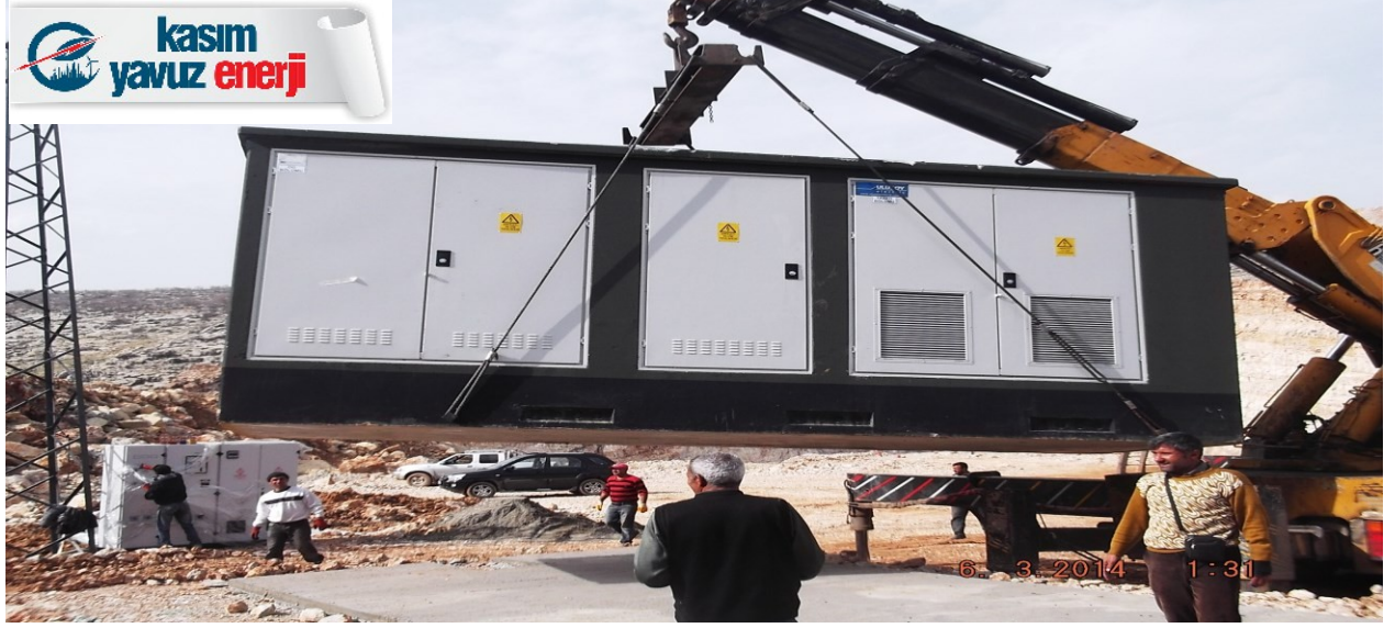
1600 KVA BETON BLOK KÖŞKÜN YERİNE KONULMASI
